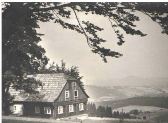
Obr. 15: Chalupa na Jedlové po základních úpravách
