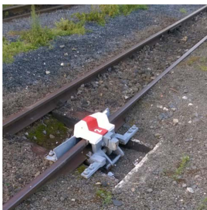
Obr. 1: Výkolejka ve stanici Osoblaha, Osoblažská úzkokolejka, trať 298 Třemešná ve Slezsku – Osoblaha. Foto autor.
